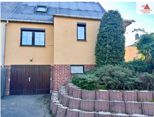
Ansicht mit Garage
