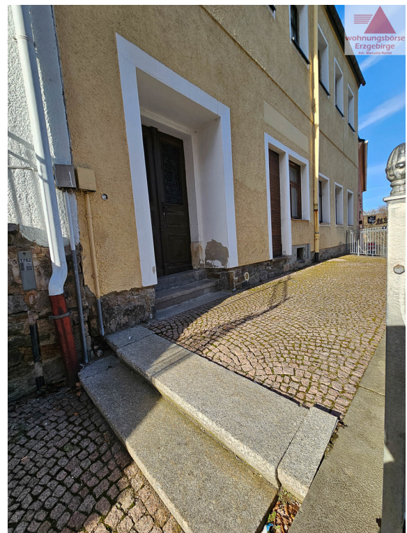
Terrasse vorm Haus
